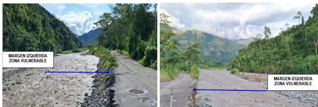
FIGURA N°04: EN LA IMAGEN SE EVIDENCIA EL ACCESO HACIA LA LOCALIDAD DE NUEVA ESPERANZA Y ANATO, SE ENCUENTRA EN RIESGO EXPUESTO ANTE EL INCREMENTO DEL CAUDAL DEL RIO ACON, ASI MISMO SE EVIDENCIA ACUMULAMIENTO DE MATERIAL ARRASTRADO.
